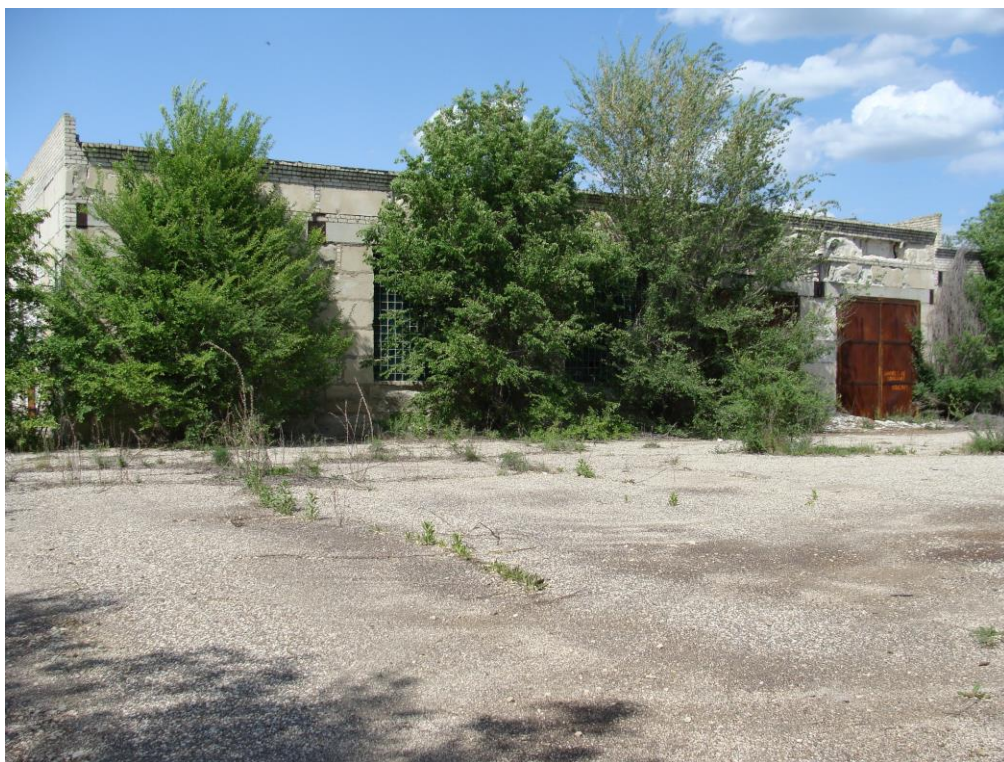
Здание ремонтно-механической мастерской
